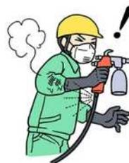
化学工場内における廃棄物焼却炉の定期補修工事で、耐火物へ耐火物の硬化時間促進剤である急結剤の吹付け作業を行っていた。その際、ノズルとホースの接続部から飛散した強アルカリの急結剤が作業員3名の皮膚に付着したことにより、3名とも薬傷（化学性皮膚炎）を負った。
